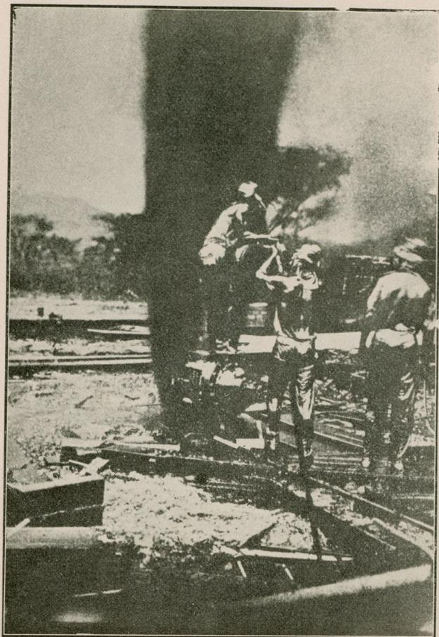
Fig. 1.—Colocación de la válvula en la boca del Pozo Cerro Azul N° 4.
