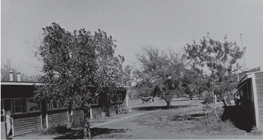
Figura 4. Alojamiento de braceros en Weslaco, Texas. Fuente: “Informe rendido por el cónsul José T. Delgado sobre su viaje de inspección al valle bajo del río Bravo y de Eagle Pass, octubre de 1955”, Archivo Histórico Genaro Estrada, AHDSREM, TM , caja 39, exp. 2
