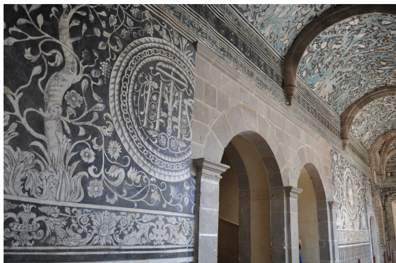
Figura 4. Vista general del muro oeste del Convento de la Transfiguración de Malinalco con la intervención posterior del acceso a la escalera que conduce hacia el claustro alto
