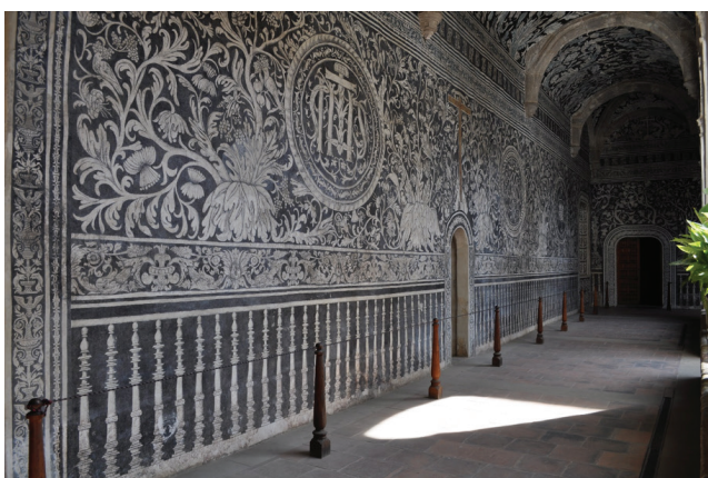
Figura 1. Vista general del muro norte del Convento de la Transfiguración de Malinalco
